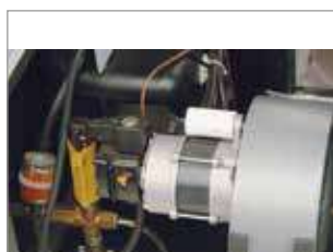
MOTEUR BRÛLEUR MONOPHASÉ, COUPLÉ AU VENTILATEUR ET À LA POMPE FIOUL
